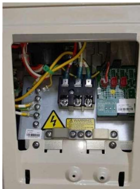
Elektronischer Teil des Außengeräts
