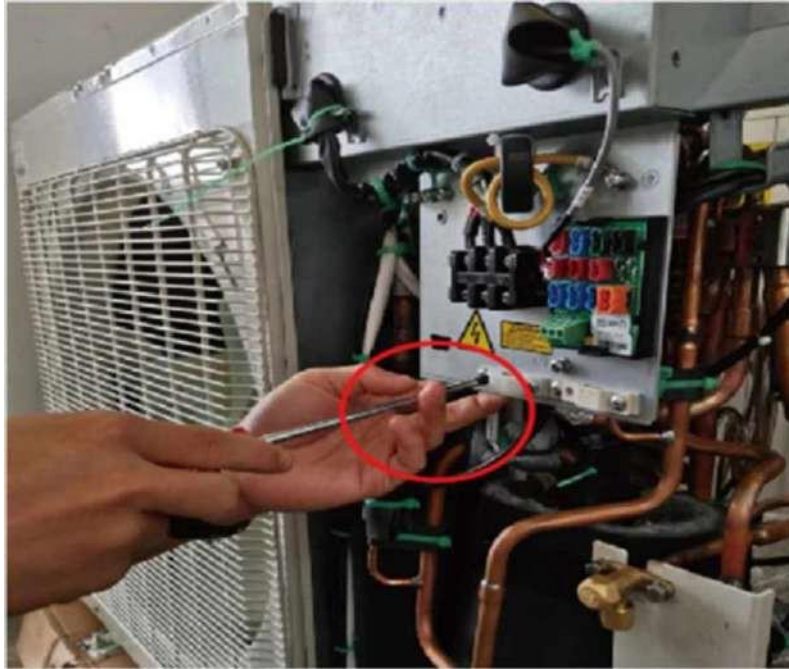
Abschrauben der Kabelklemme des Außengeräts
