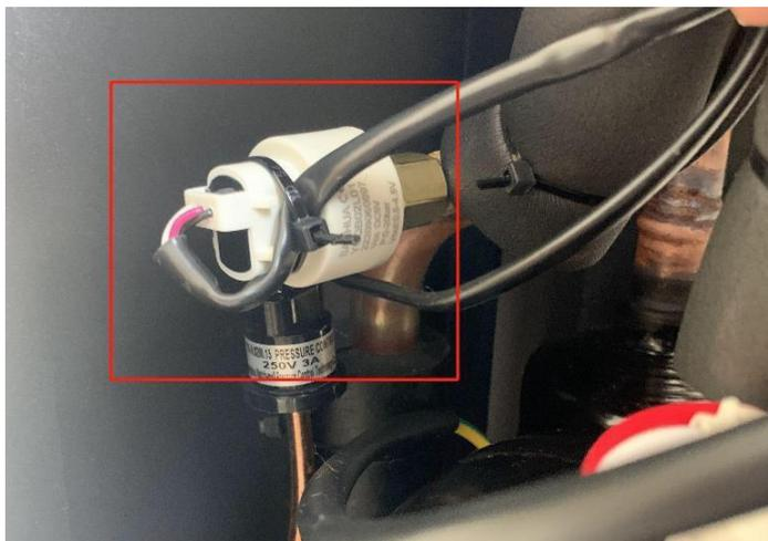
1. Ist die Anschlussleitung des Sensors getrennt oder kurzgeschlossen
